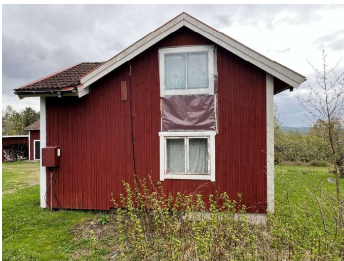
Foto. Huvudbyggnad. Kortsida mot norr.
