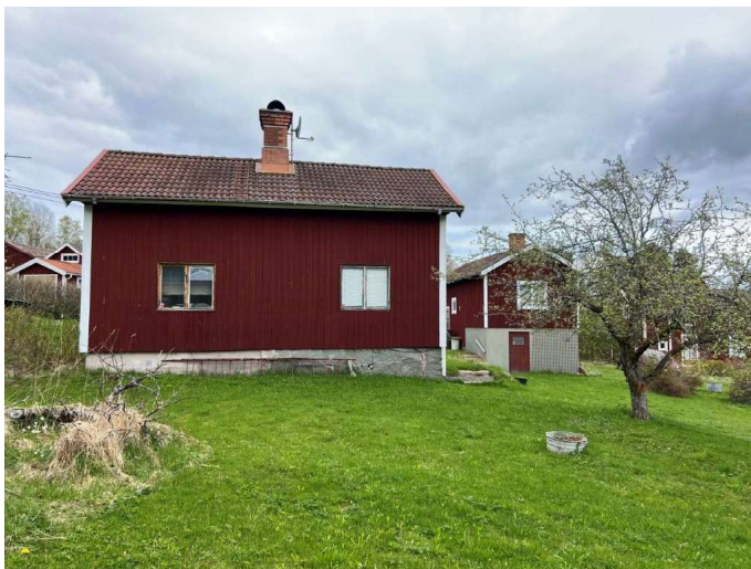
Foto. Huvudbyggnad. Längsida mot väst.
