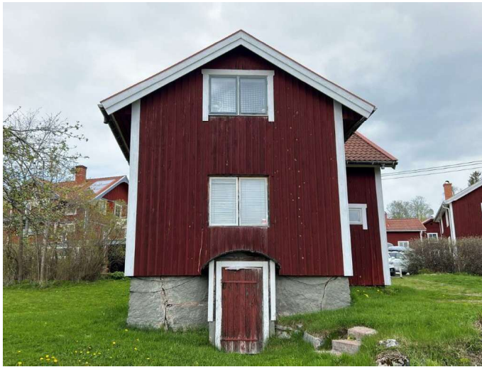
Foto. Huvudbyggnad. Sydgavel med matkällare.
