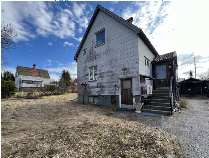
Foto, huvudbyggnad, fasad med eternitplattor, entré via förstuga.
