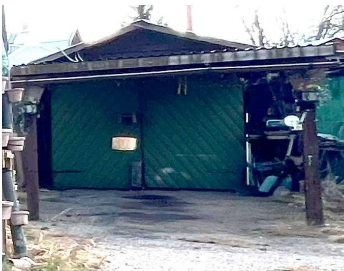
Foto, byggnad 2, garagebyggnad med vidbyggt förråd.
