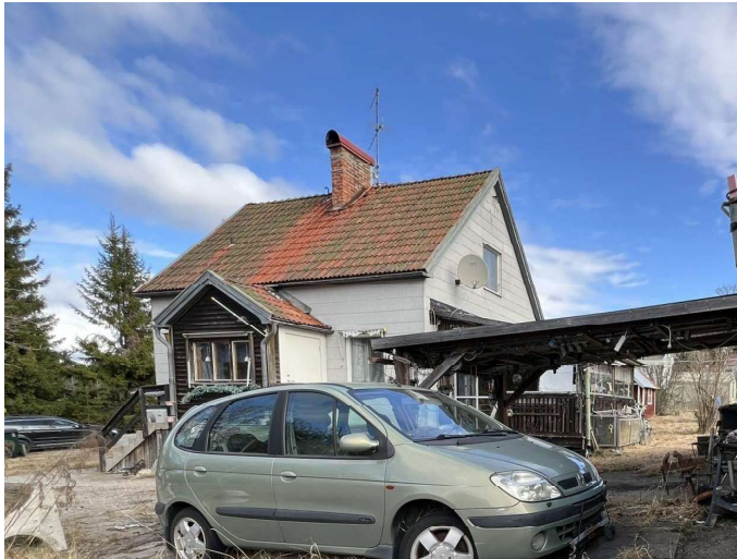
Foto, huvudbyggnad, fasad med eternitplattor.
