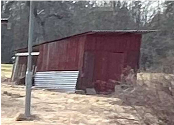
Foto, byggnad 3, friliggande förråd.
