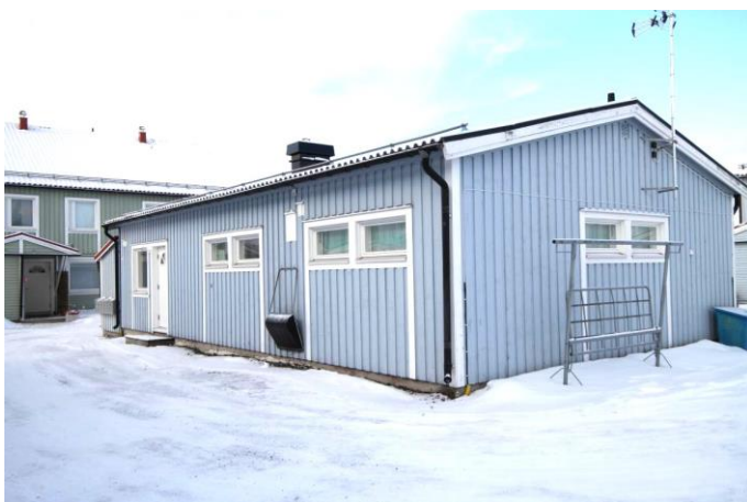
Foto, tvättstuga och bastu, ljusblå träpanel, vita detaljer.
