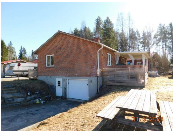
Foto, huvudbyggnad, norra kortsidan, infart till inbyggt garage.
