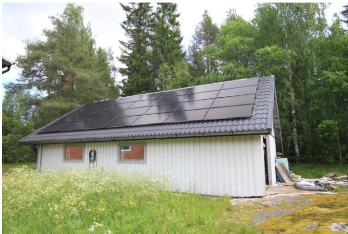
Foto, garage med vit träpanel, svart plåttak med solpaneler.
