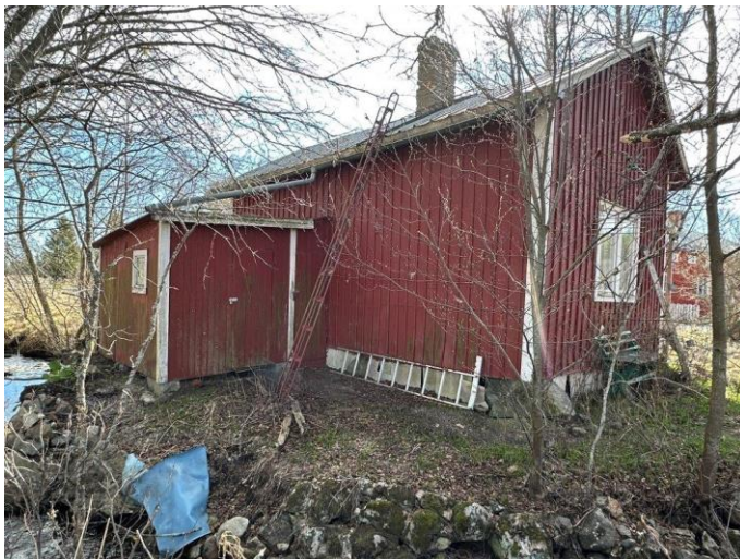
Foto, fasad mot baksidan av stugan med vidbyggt förråd/vedbod/utedass.
