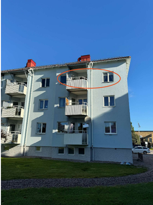
Foto, huvudbyggnad (Putsad fasad med balkonger)
