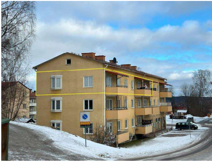
Foto, lägenhetens fasad mot sydväst med två balkonger
