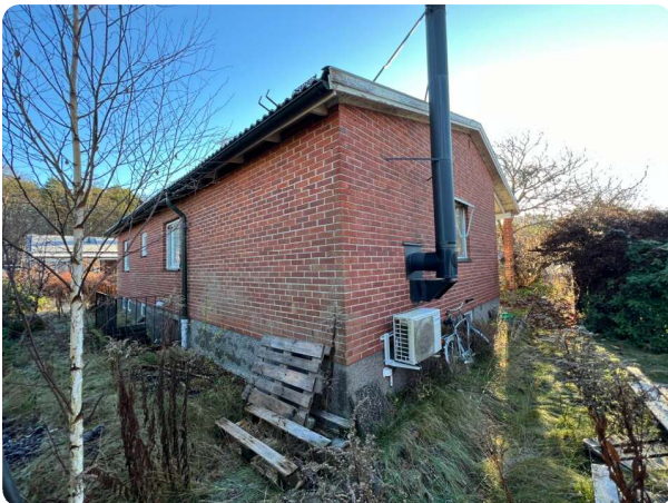
Byggnad med tegelfasad samt gräs, buskar och träd, vy från baksidan
