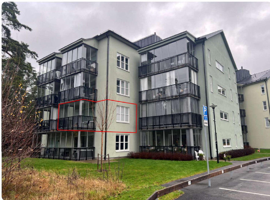
Flerbostadshus med grön fasad och inglasade balkonger, värderingsobjektets läge markerat.
