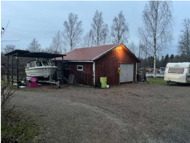
Foto, byggnad. Garagebyggnad samt grusad markyta.
