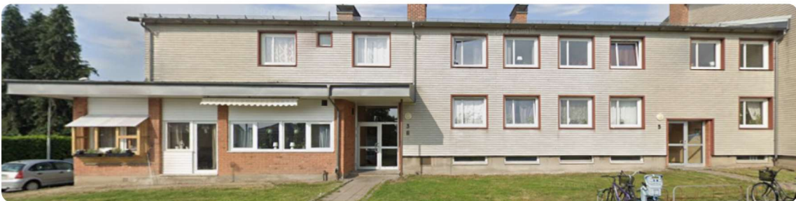
Huvudobjekt, ljus fasad med bruna detaljer
