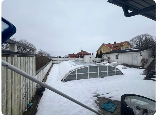
Altandäck med pool samt del av garagebyggnad och plank
