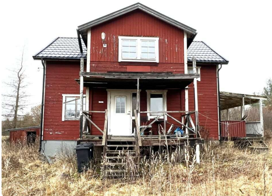
Husets entrésida mot söder, med tak över veranda
