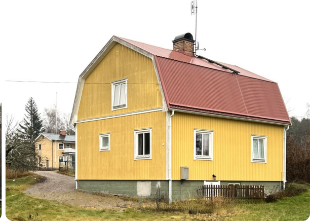
Fasad mot norr. Dags för tvätt och underhållsmålning
