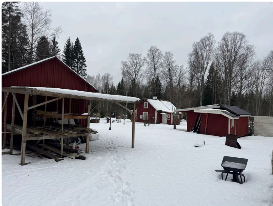
Foto taget utvändigt på värderingsobjektet. Röd träpanel med betongpannor samt gäststuga och kallförråd
