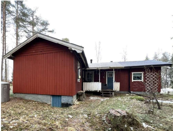
Foto. Bostad, fasader mot sydväst (Hällsjön 4:67)
