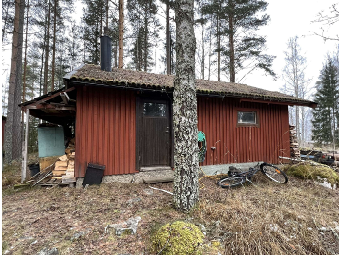
Foto, garage/verkstad, fasad mot sydöst.
