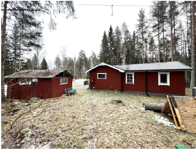
Foto, huvudbyggnad och carport. Vy från nordväst.
