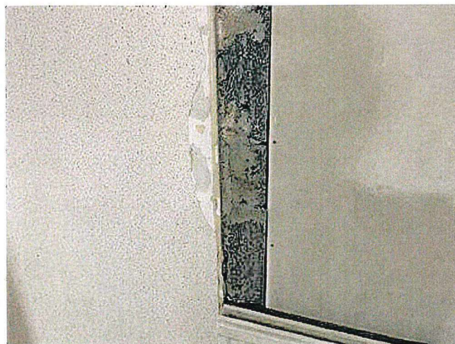
Vägg i källare med påreglad väggkonstruktion samt skymtas blåbetong.
