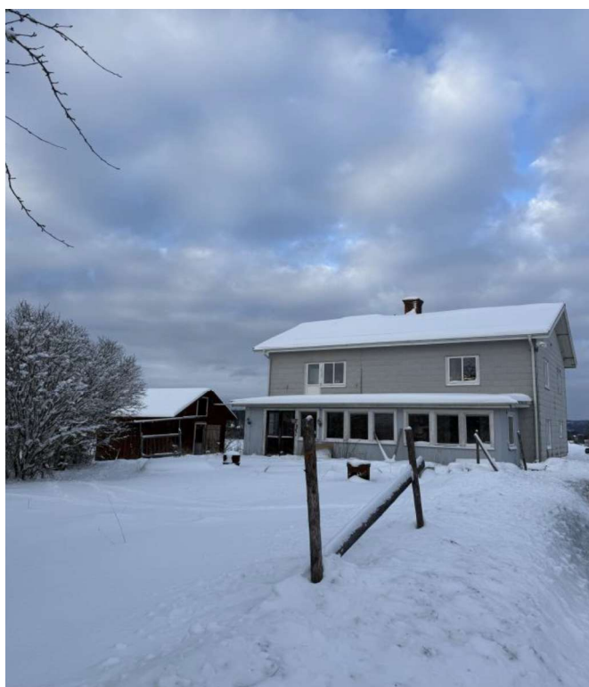
Foto taget utvändigt på huvudsakligt bostadshus vid Ivarsbjörke 263. Byggnad med fasad av eternit omgiven av betesmark.
