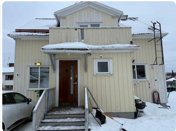
Värderingsobjektets entré. Trappa upp till ytterdörr med balkong över.
