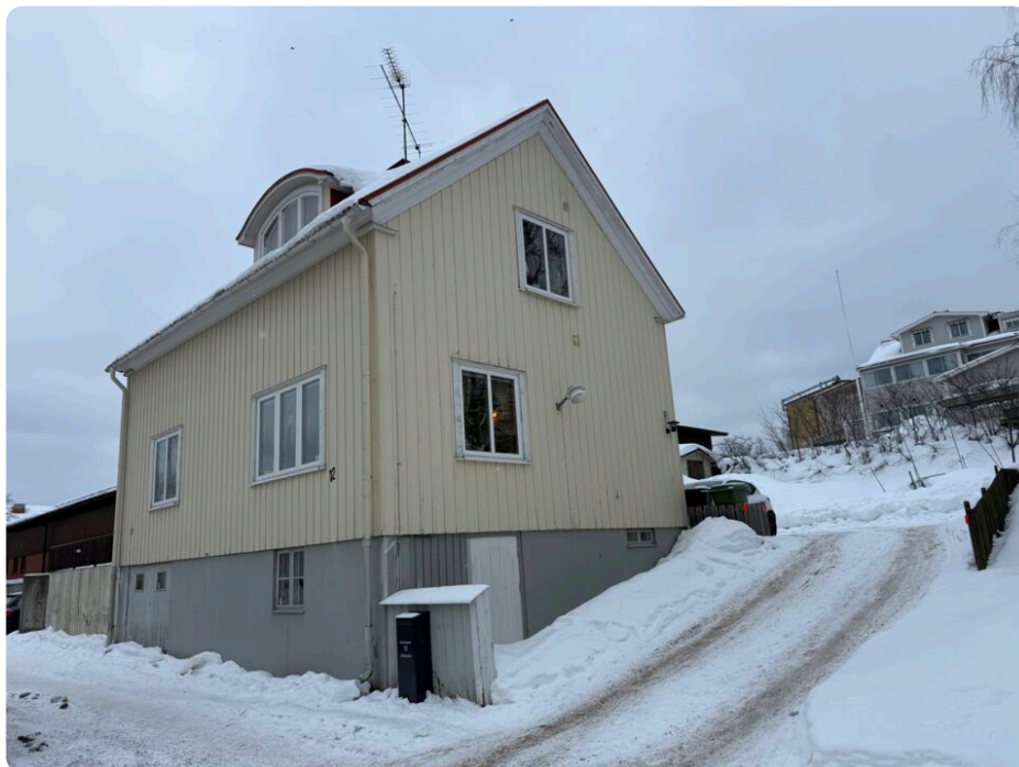
Värderingsobjektet från Åsbäcksgatan. Ljusbul fasad med vita detaljer. Garageinfart ses i bild.
