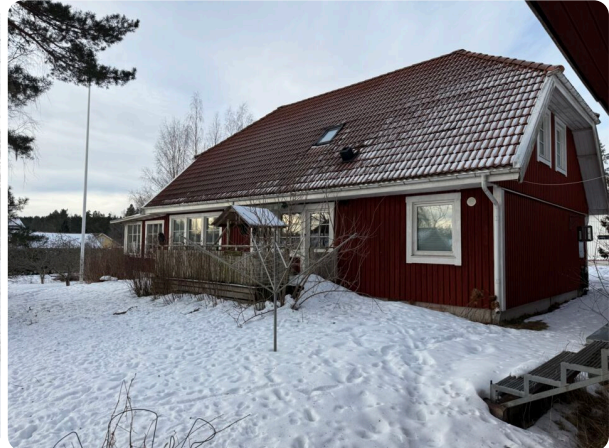
Huvdbyggnadens baksida. Trädgård samt altan. Takfönster på övervåningen.
