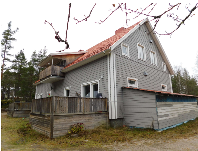
Foto, huvudbyggnad, östra gaveln baksida.
