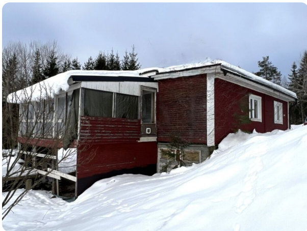
Fasader mot sydost
