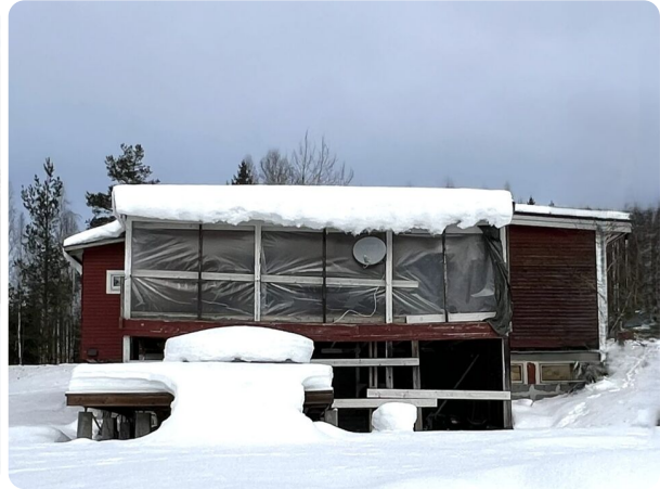
Fasad mot syd. Ej färdigställd inglasning av altan. Tillbyggnader: Entré (vänster i bild) samt sovrum (höger i bild).
