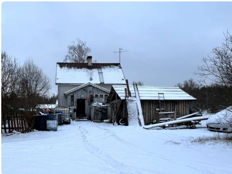
Bostaden med förstuga och vedförråd (höger förgrund)
