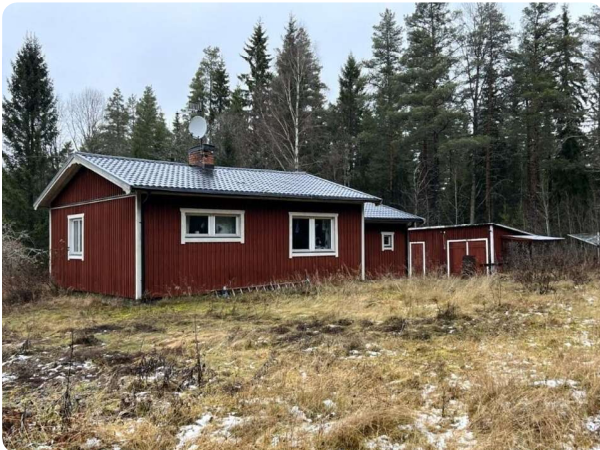
Bostaden. Fasader mot syd.
