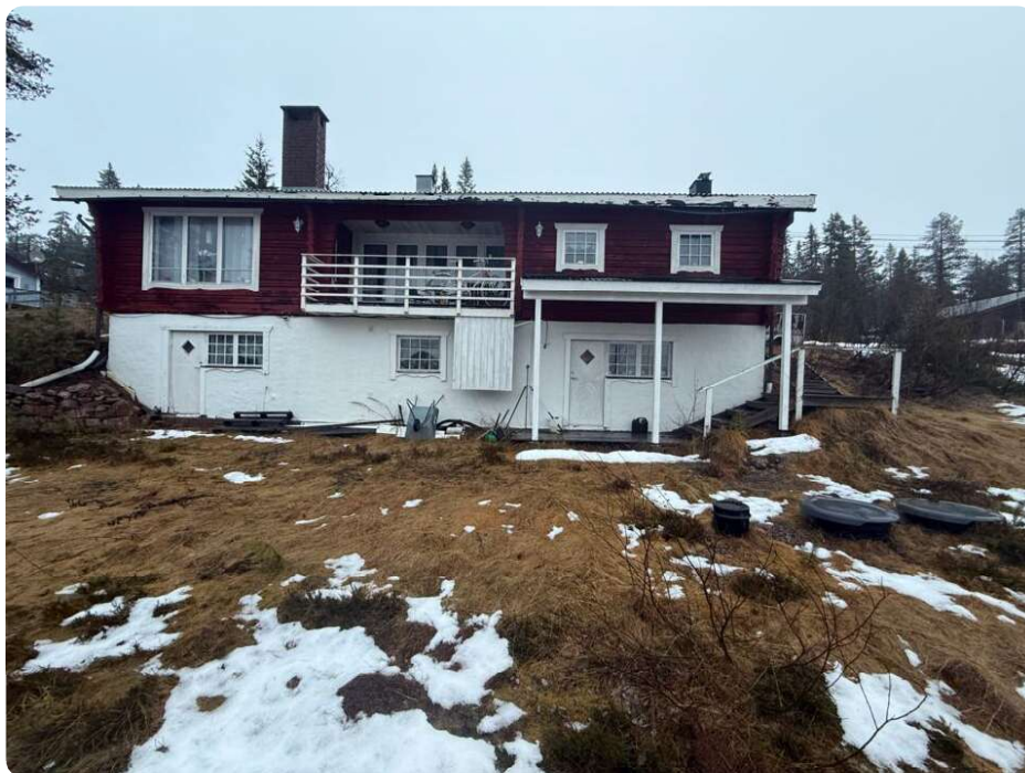
Värderingsobjektets baksida. Röd timmer och vitmålad källare. Balkong finns.
