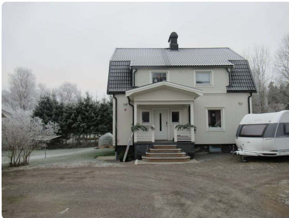
Byggnad med vit träfasad samt trädgård med buskar och träd
