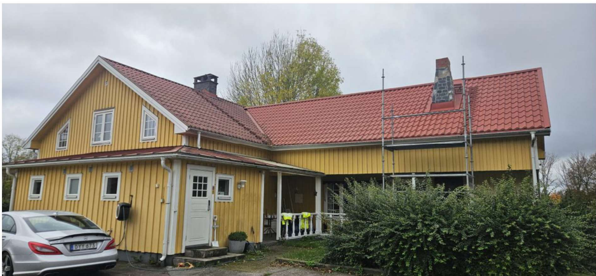
Huvudbyggnad från sidan. Reparation av skorsten pågår
