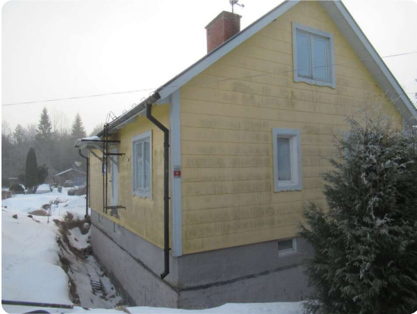
Vy från sida med påbörjade dräneringsarbeten
