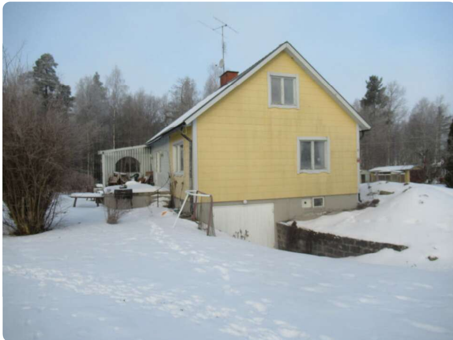
Byggnad med gulmålad eternitfasad samt rymlig trädgård.
