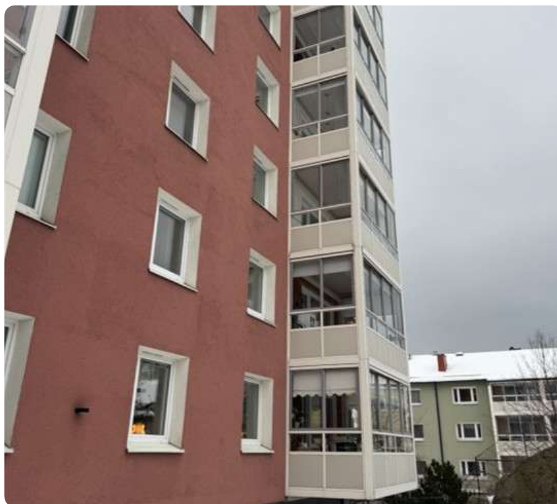
Foto taget utvädligt på värderingsobjektet. Inglasad balkong på våning 3. Putsad fasad.
