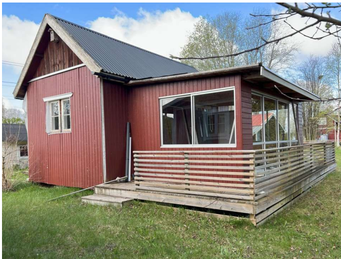
Foto. Övrig byggnad 3. Uppvärmad stuga. Ansluten till el.
