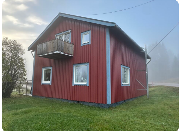
Fasad mot vägen och gavel. Röd träpanel samt vita och blåa detaljer
