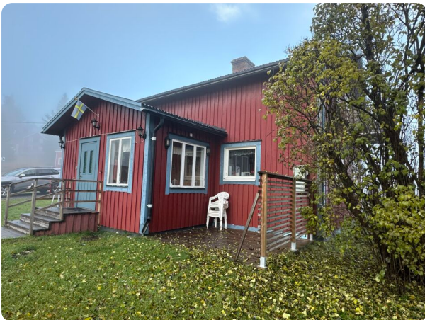
Entréfasad bostadshus samt uteplats
