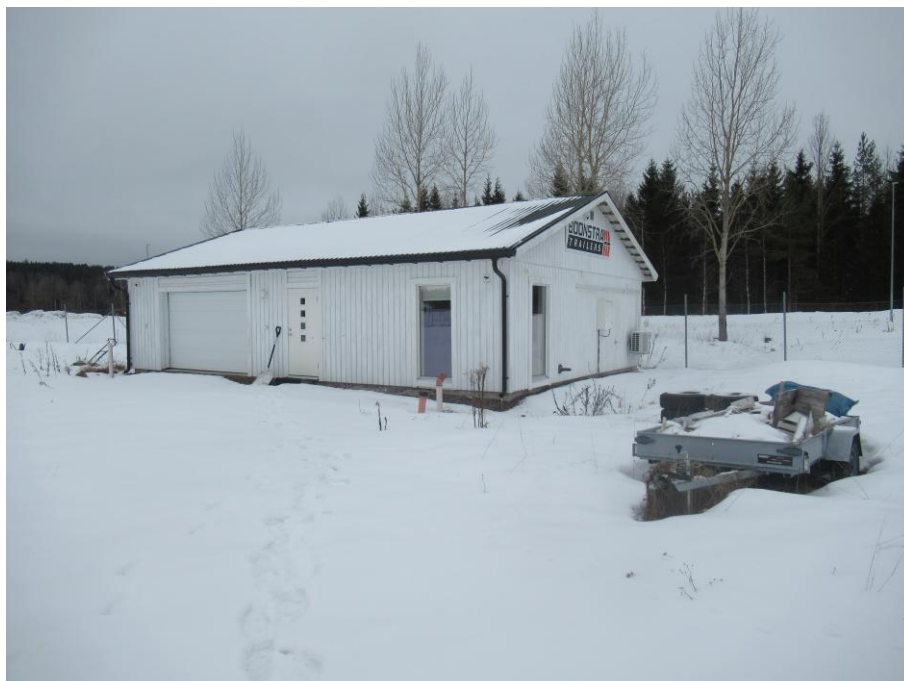
Foto taget utvändigt på värderingsobjektets huvudbyggnad. Vitmålad träpanel med vita och detaljer samt plåttak samt inhägnat.
