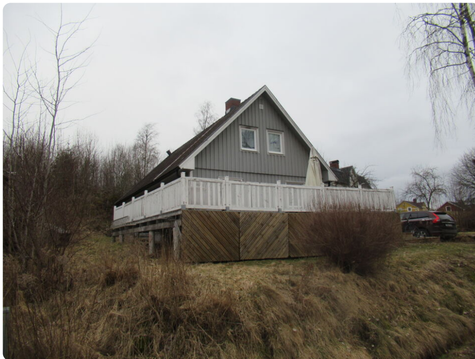
Byggnad med grå/blå träpanel
