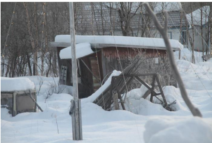
Foto, gammal förrådsbyggnad. Trästomme, träpanel.
