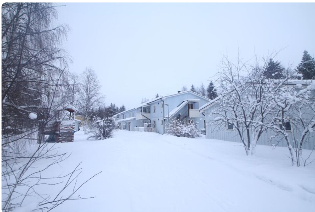
Foto byggnader. ljusblå träpanel, vita detaljer, snöbeklädd mark.
