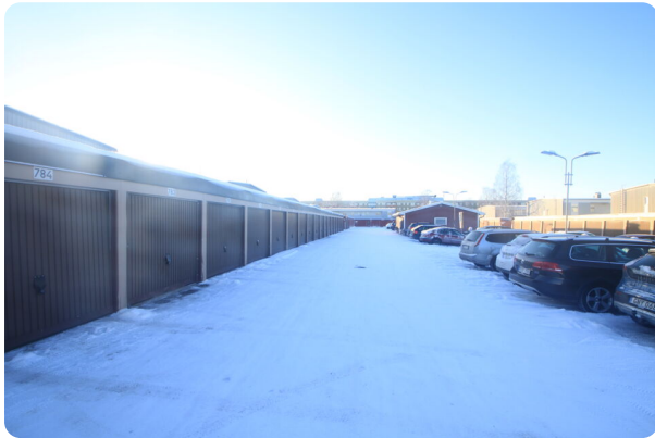
Foto garagelänga och parkeringar.
