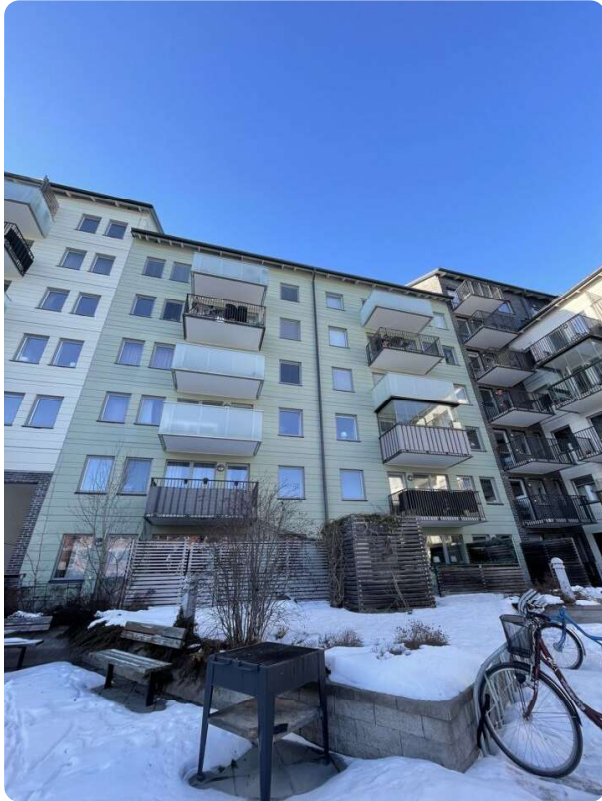
Baksida med innergård.
