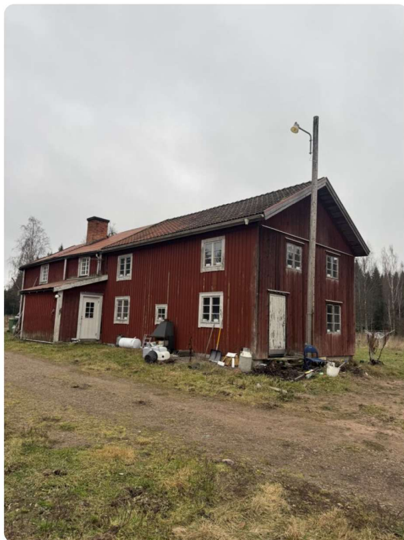
Foto taget utvändigt på värderingsobjektet. Röd Träpanel med betongtegel.
