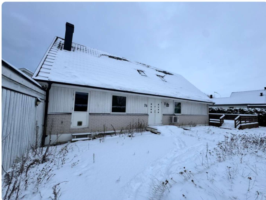
Huvudobjekt, Vit fasad av trä samt tegel med ljusa detaljer
