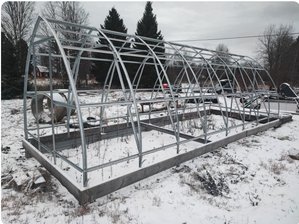
Påbörjad byggnation av växthus
