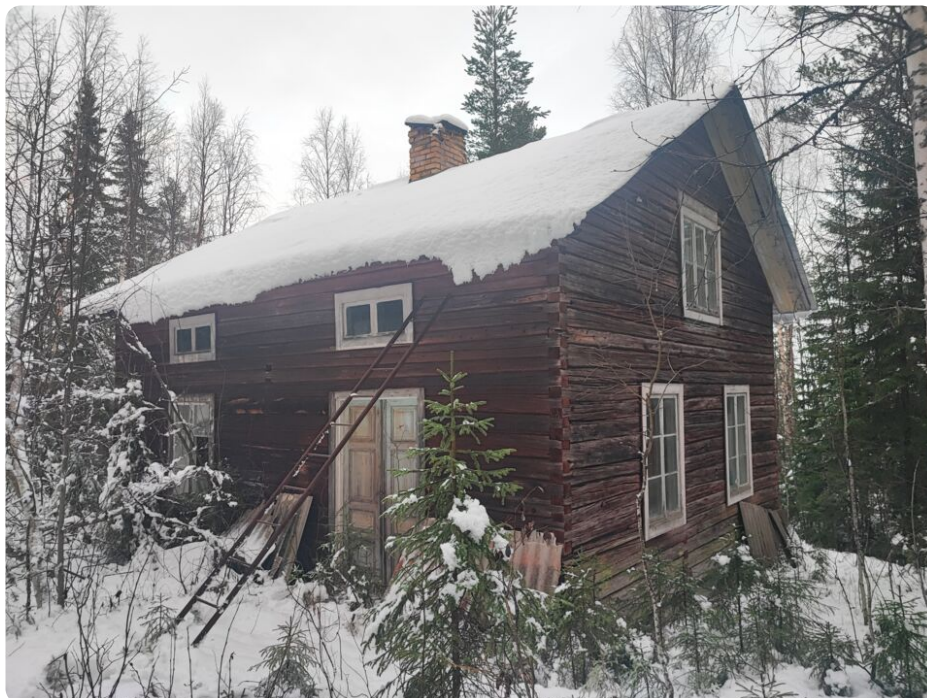
Foto huvudbyggnad med timrad fasad, taket snötäckt
