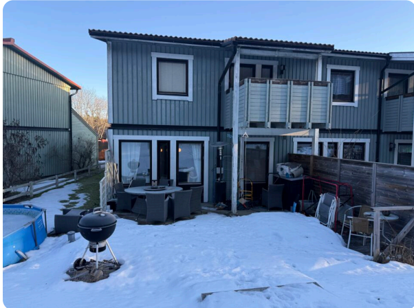
Värderingsobjektets baksida. Gråmålad träpanel med vita detaljer och bruna fönster.
