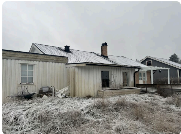
Bostadshus med tillbyggnad samt vildvuxen gräsyta, vy från baksidan
