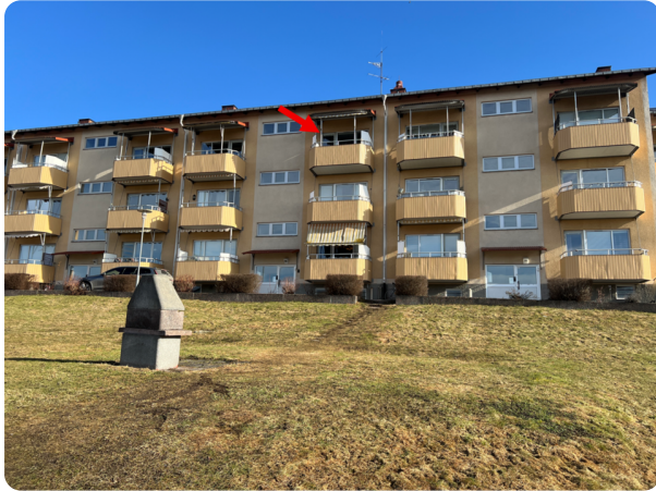
Flerbostadshus med gul fasad och balkonger, värderingsobjektets läge markerat.
