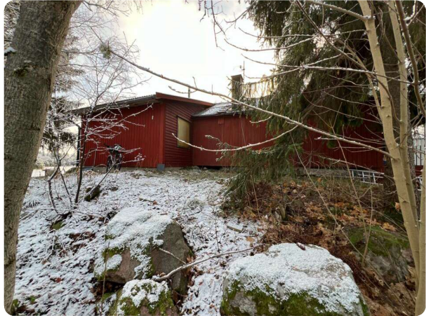
Bostadens långsida mot norr. Tillbyggnaden till vänster i bild
