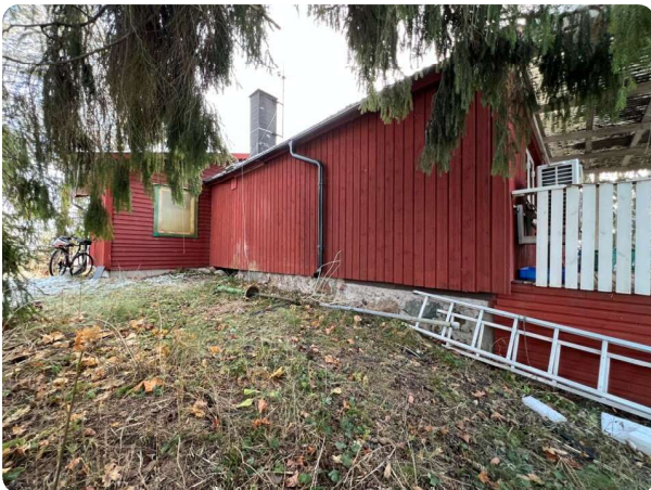
Bostadens långsida mot norr. Äldre del uppförd på kryppgrund
