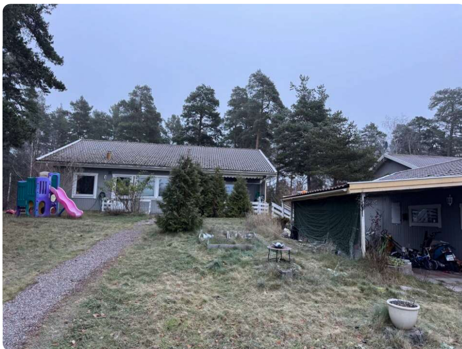
Parhus i träpanel och betongtegel med carport och förråd
