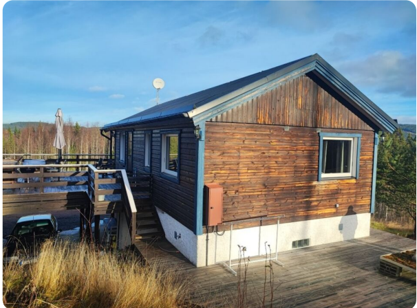
Foto, vy mot baksidan av huset
